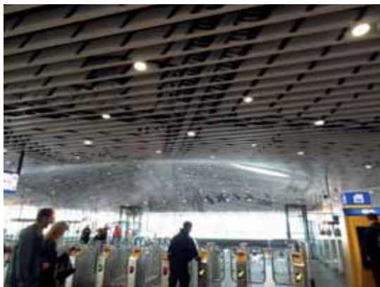
Nieuwe station Delft
