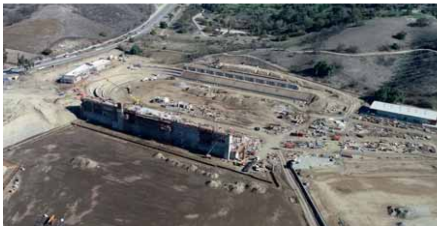
Overzichtsfoto van de stand van zaken rond de verbouwing van het Hilmer Lodge Stadium in Walnut eind vorig jaar. (foto Tilden-Coil Constructors)
